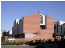
Quattro edifici in area Peep, Dosson di Casier (Tv) 2004-2007
